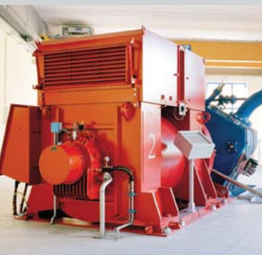
Italy DIG150 (2500kVA)
